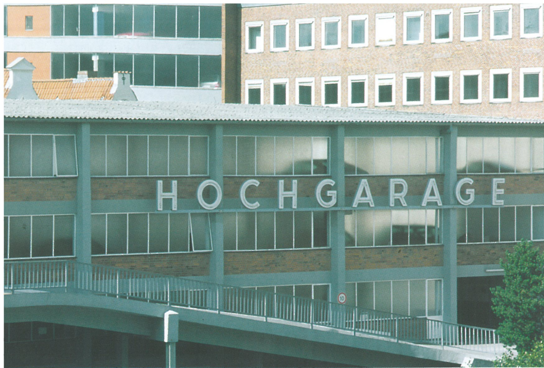
1955 | Hochgarage und Pavillon (1958) Marlesgrube 18-30, 23552 Lübeck
