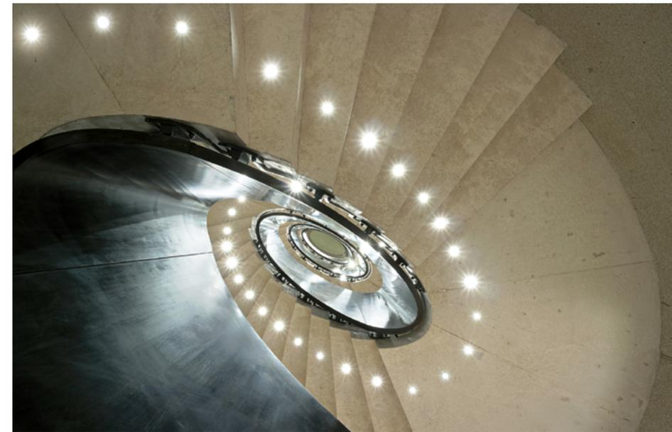
Im Treppenauge windet sich eine Stahlgeländerkonstruktion in die Höhe, die Stufen – gestockter, mit Natursteinzuschlagstoffen versetzter Beton – liegen makellos auf Abstand zum Stahlbau. Auch die Schaukästen sitzen akkurat in den runden Treppenhauswänden; in den durchaus beengten Verhältnissen entstand eine geradezu großzügige Atmosphäre.
