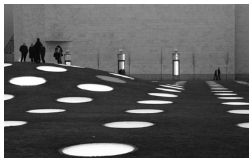
Gute Architektur, auch unter der Erde: Das Kunstmuseum Stuttgart von Hascher Jehle Architektur, die Städelerweiterung von Schneider + Schumacher in Frankfurt sowie das Literaturmuseum der Moderne in Marbach, David Chipperfield Architects.
