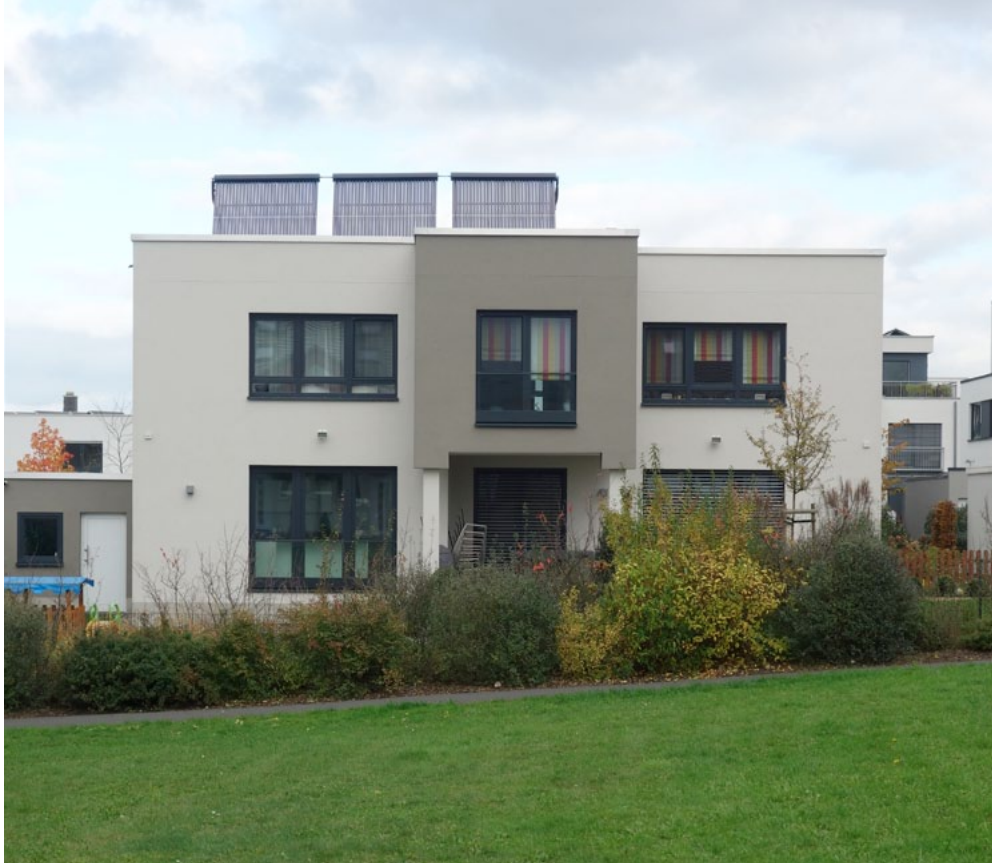
Wärmedämmung und Sonnenkollektoren allein sind zu wenig. (Bild: C. Holl)
