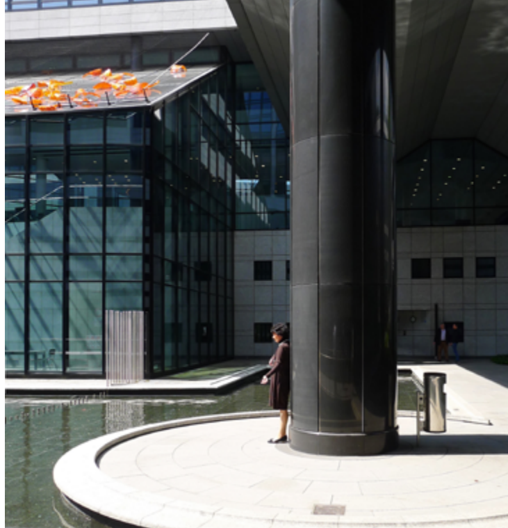
Neubau im Bereich der Stuttgart 21-Stadtzentrumserweiterung. Was auf dem Glasdach nach Herbstlaub aussieht, ist ein Stück „Kunst am Bau“. (Bild: Ursula Baus)
