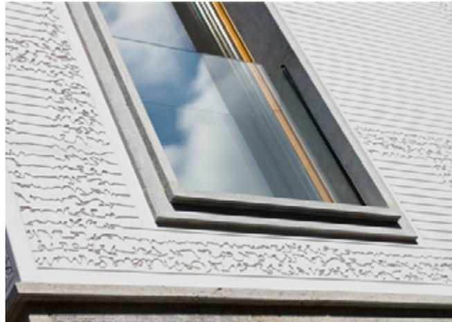
Gestalten mit Wärmedämmung – je nach Lichteinfall zeichnet sich das in die massiven Fassadenplatten gefräste Fachwerk des Vorgängerbaus ab (Architekten: Franken Architekten, Frankfurt am Main, Fotos: Sto, Stühlingen).
