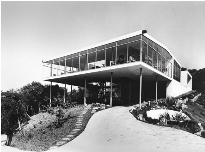
Casa de Vidro, São Paulo, 1949-1951, Außenansicht kurz nach Fertigstellung. Bardi bewohnte dieses Haus bis zu ihrem Tod 1992. Da war es längst vollständig eingewachsen. Bild: Arquivo ILBPMB / Peter Schleier, 1951
