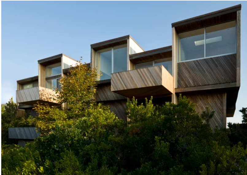
Horace Gifford: Lipkins House, Fire Island, 1970. Das Haus verfügt über einen fensterlosen „Höhlenraum“, in den man vom Wohnzimmer aus hinunter steigt. Er war ein Wunsch der Bauherrn, um sich bei Bedarf den voyeuristischen Einblicken von Wohn- und Essbereich entziehen zu können. (Copyright: Michael Weber)
