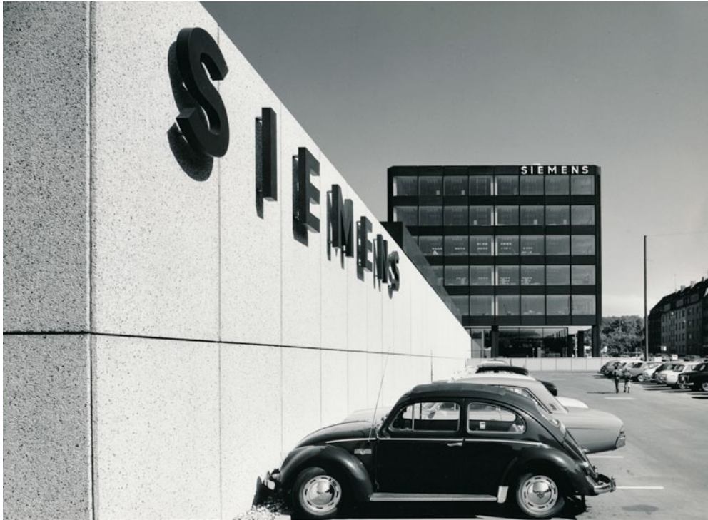
Siemens Zweigniederlassung in Saarbrücken (1966). Das Gebäude steht derzeit leer und wartet darauf, angemessen neu genutzt zu werden. (Bilder: Archiv von Seidlein)
