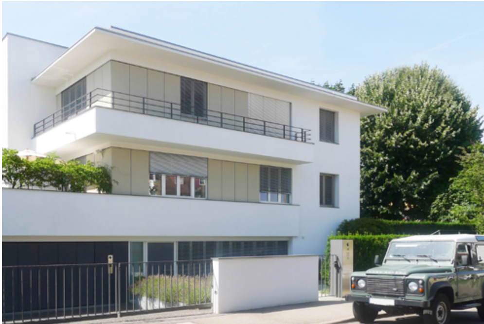
Nobelviertel in Kapstadt: Die großen Fensterflächen sind durch Dachüberstand und Jalousien verschattet.
