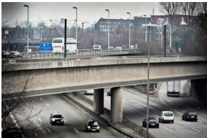
103.123 Autos durchqueren auf der A46 täglich Wersten, als Hochtrasse darüber die Werstener Straße – weit und breit ist die Gegend unbewohnbar. (Bild: Andreas Endermann)
