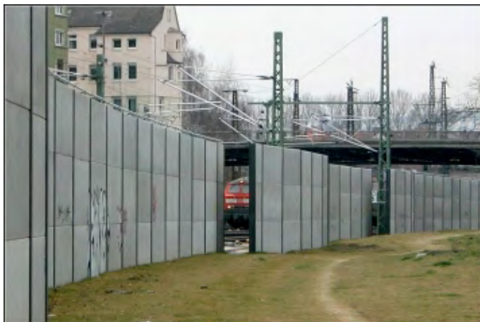
Eine innerstädtische Lärmschutzwand der Bahn – verlorenes Terrain (Bild: Grüne Liga)
